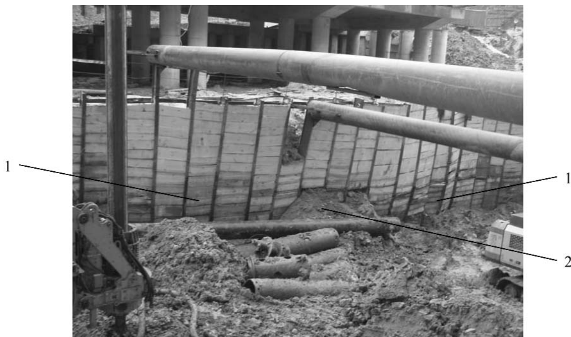
Рис. 6. Замокання та випадіння дощок забірки з вивалом ґрунту: 1 – місця замкання дощок забірки, 2 – випирання ґрунту
