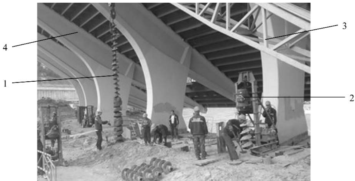
Рис. 4. Буріння свердловини та дістання шнекової колони зі свердловини:
